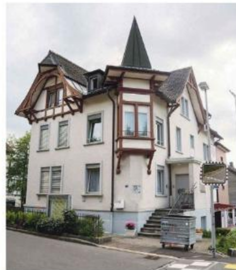
Die beiden Liegenschaften mit den Häusern Flora (links) und Sonneck sollen verkauft oder im Baurecht abgegeben werden.
